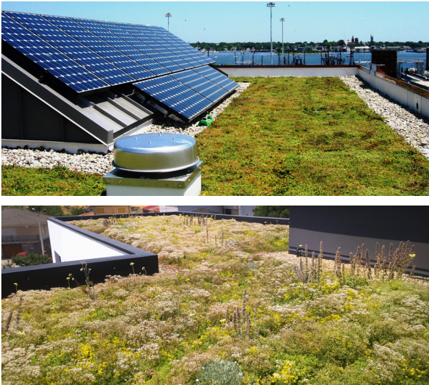
Figura 51, 52: Fotos del techo Comunal Co-Working. Fuente: aimsur ©, 2025.
