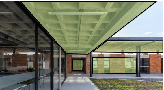
Figura 33: Interior del centro de atención diurna Macas, Ecuador.
