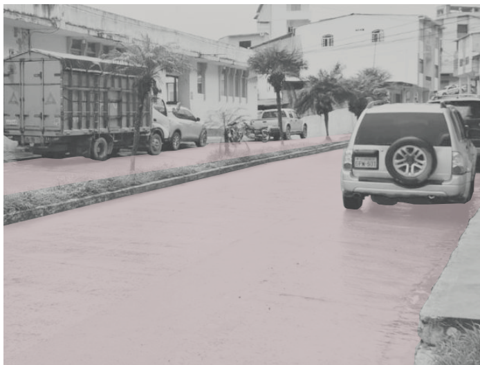
FIGURA 17. Proyecto de parterre inconcluso tramo 1
