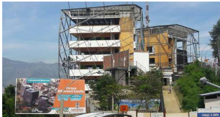
Figura 34. Construcción de la Biblioteca España
