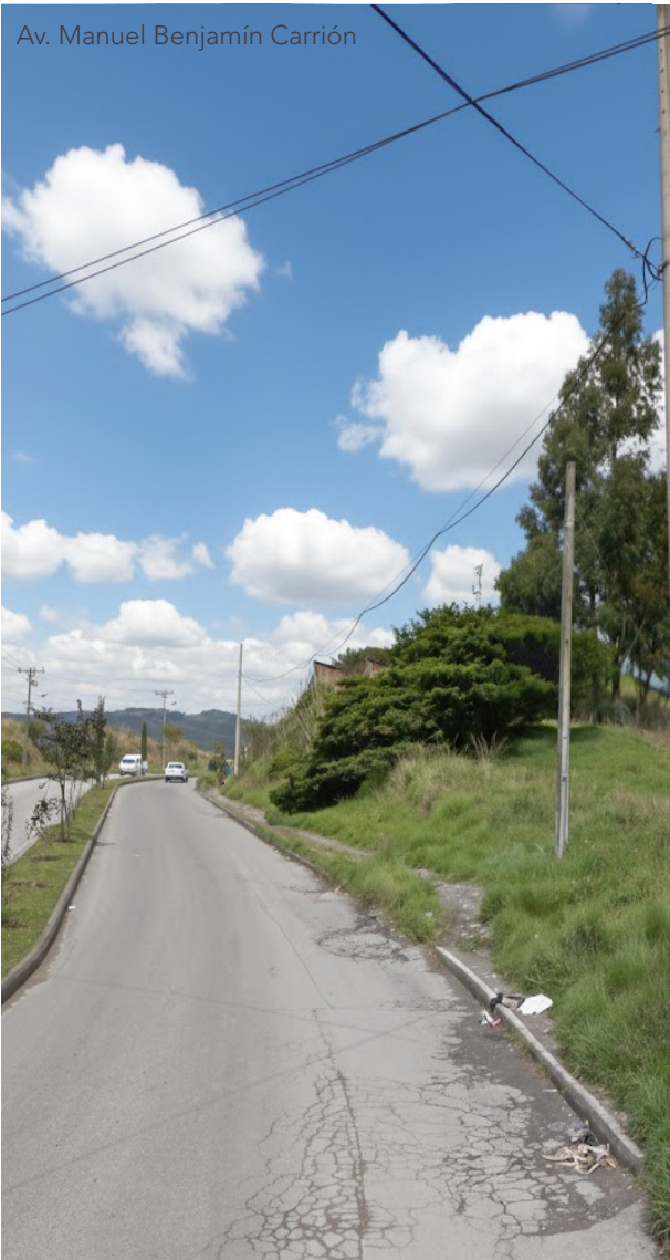
Figura 87. Via con deficit de alumbrado publico y Via estrecha Calle Jose Ortigas
