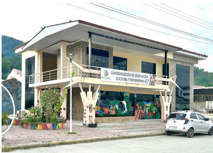
Figura 22. Fachada Frontal del Centro Cultural actual. Autor: Elaboración propia, 2026.
