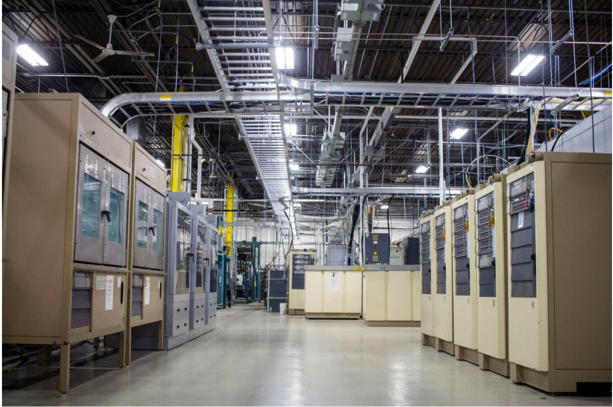
Figura K.3. Laboratorio equipado para ensayos hidráulicos.
