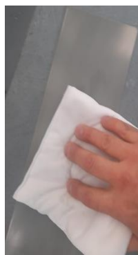
Limpieza del área de aplicación
