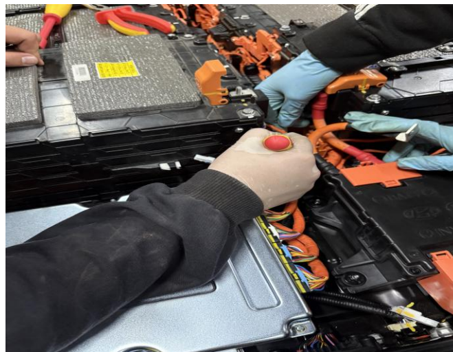
Figura 27 Extracción de paquete de baterías EV
