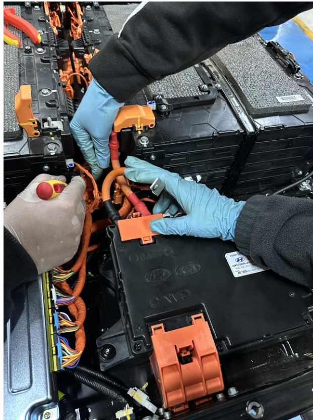
Figura 38 Reconexión de conectores de alta tensión
