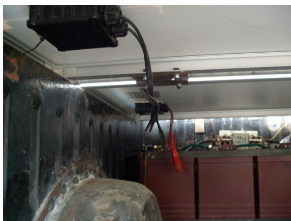
Figura 3.42 Conexiones en serie de los paneles
