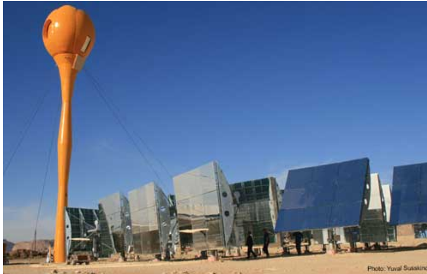
Figura 1.12. Central eléctrica termosolar-biocombustible. 12
