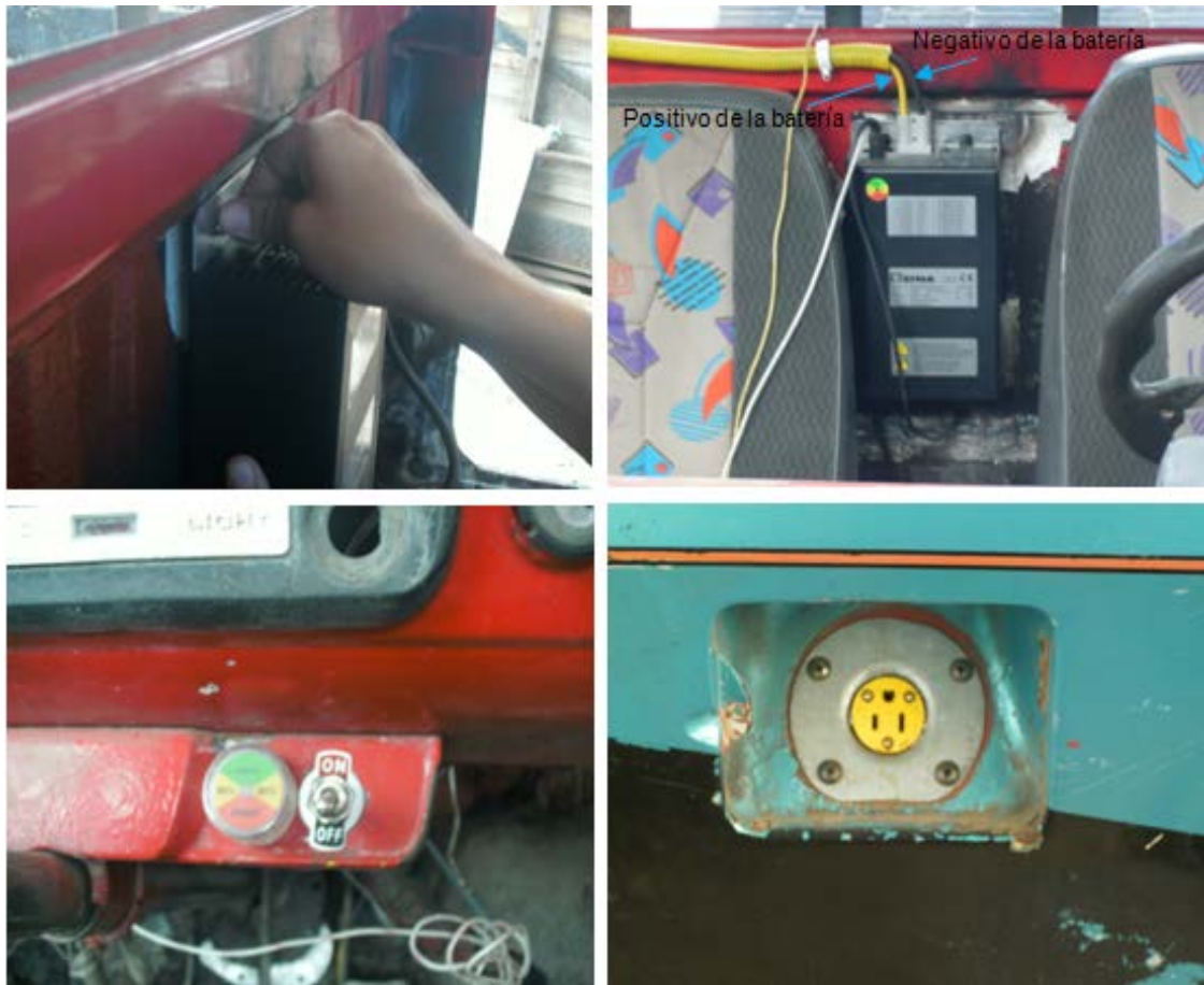
Figura 3.47 Instalación del cargador de baterías
