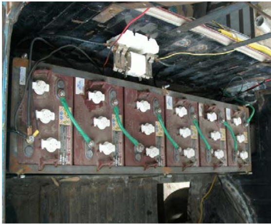
Figura 3.50 Banco de baterías posterior de la camioneta
