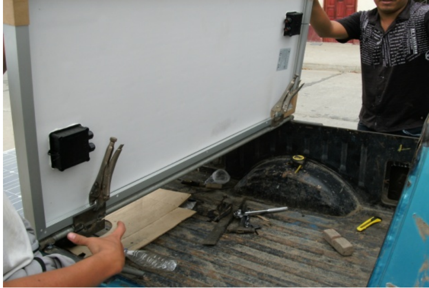
Figura 3.37 Instalación de bisagras en los paneles
