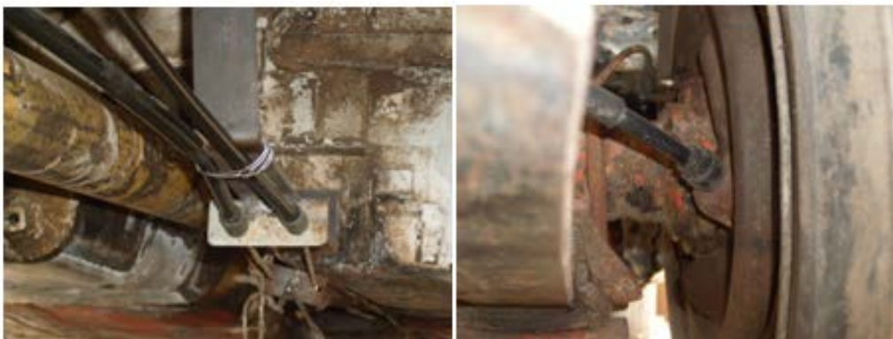
Figura 3.31 Adaptación de cables de freno de mano
