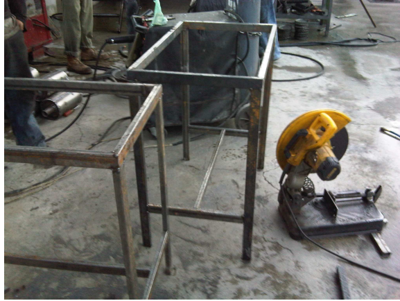
Figura N°4. 10 Estructuras de las mesas terminadas
