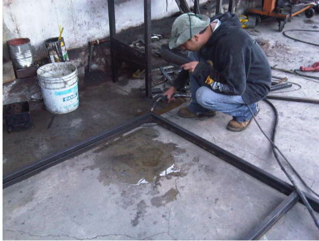
Figura N°4. 111111 Proceso de soldadura de divisiones de las cabinas
