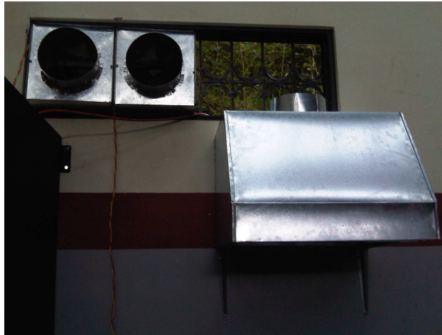
Figura N°4. 212121 Montaje de los extractores
