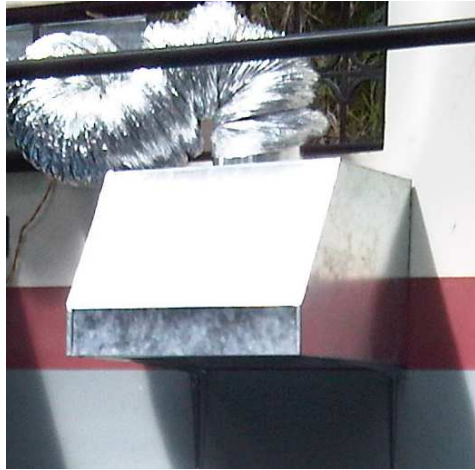
Figura N°4. 252525 Instalación del extractor de humo
