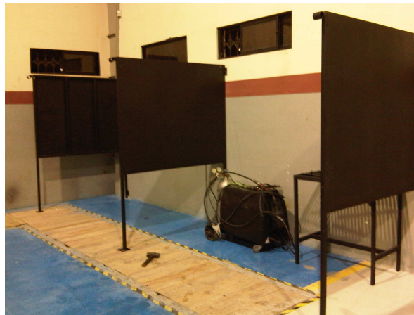
Figura N°4. 202020 Montaje de divisiones de las cabinas
