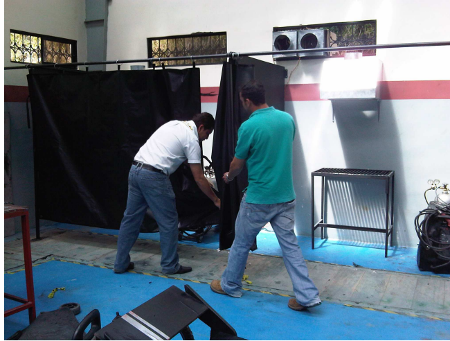
Figura N°4. 222222 Montaje de las cortinas de protección
