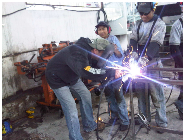
Figura N°4. 555 Proceso de soldadura de las mesas
