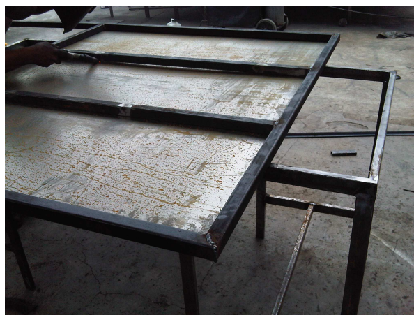
Figura N°4. 141414 Proceso de soldadura de las divisiones
