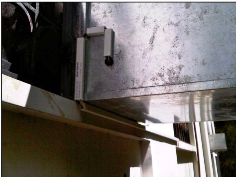
El siguiente paso fue cubrir el cableado que se encuentre en el exterior con una canaleta plástica para evitar que se deteriore con el tiempo, de igual manera probamos que la base del extractor este sellada para que no ingrese agua al interior y pueda dañar el sistema eléctrico.
