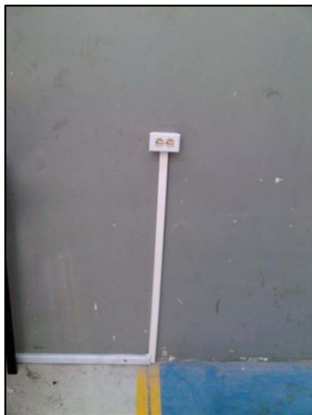
Verificamos que el punto No.2 esté funcionando correctamente conectando la soldadora y un taladro.
