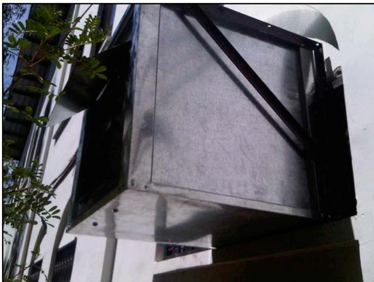
Soporte instalado en el exterior con ángulos de sujeción.
