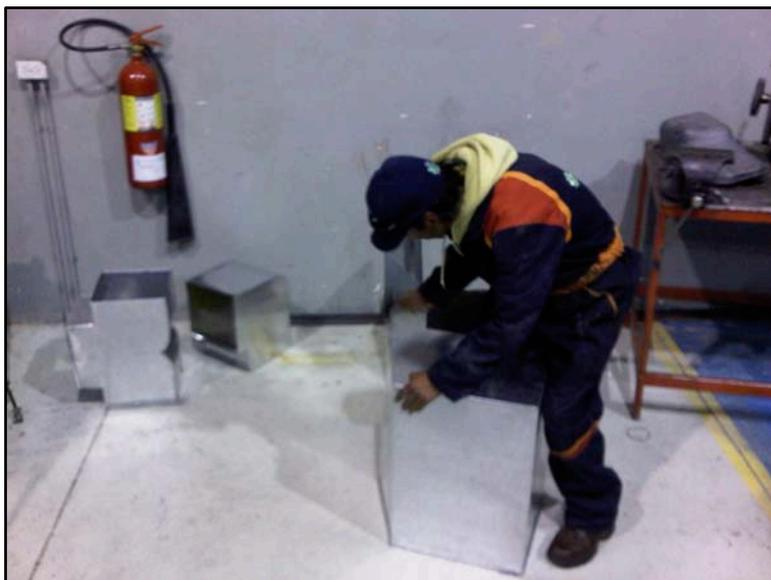
En el sellado de los ductos se procede a poner una cinta adhesiva para evitar que escape el aire succionado por las uniones de los ductos.
