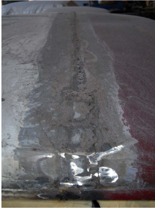
Gráfico 89 Lijado de techo vista superior
