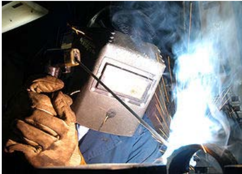
Gráfico 33 Soldadura de metal por arco. 1
