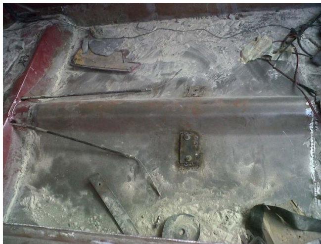
Gráfico 46 Soldadura del piso antes mencionado.
