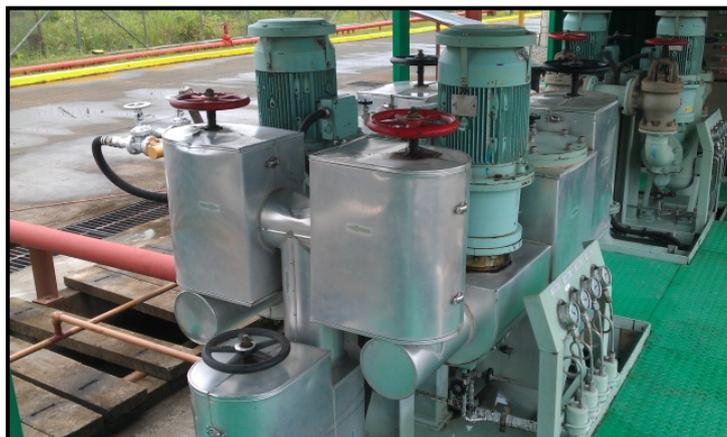
Figura 18 Bomba de Recepción de Fuel-Oil
