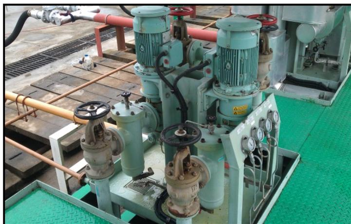
Figura 21 Bomba de Trasiego de Diesel
