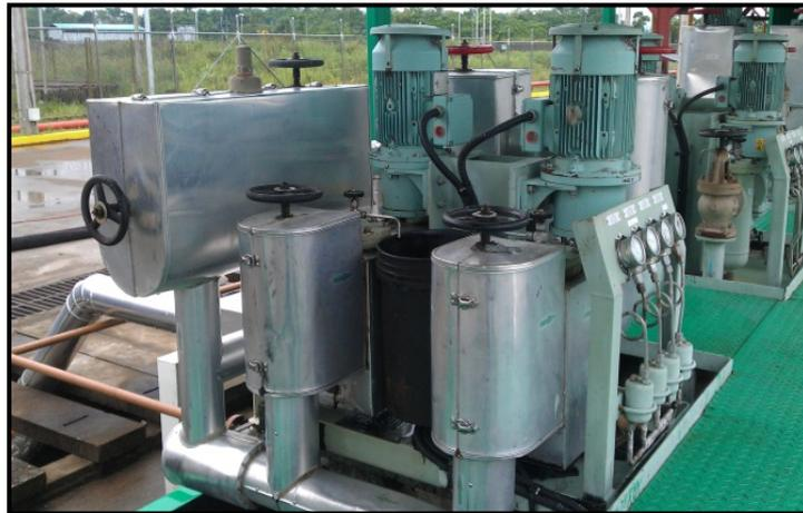
Figura 20 Bomba de Trasiego de Fuel Oil
