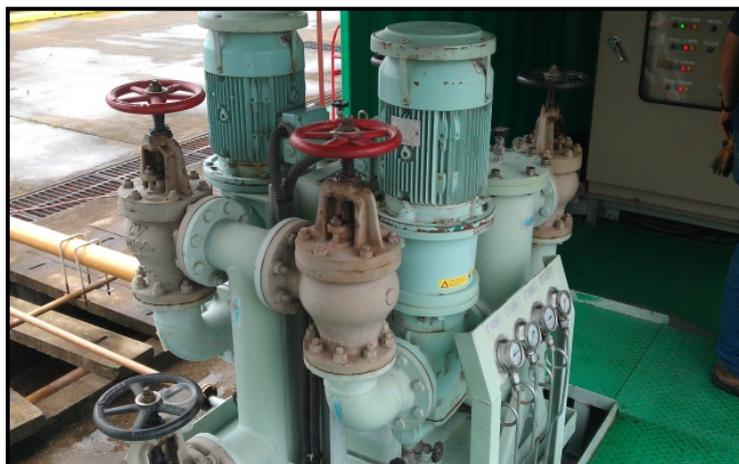
Figura 19 Bomba de Recepción de Diesel
