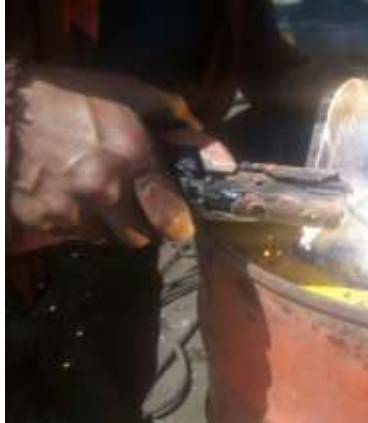
Figura 4.4. Soldadura manual por arco con electrodo revestido.
