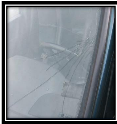
Figura 1. 25: Fractura de vidrio laminado.
