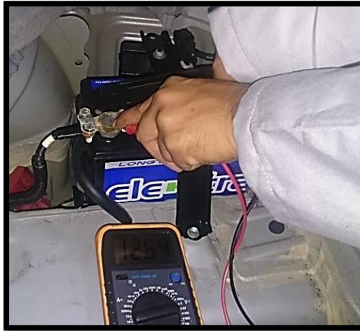
Figura 2.7. Medición de tensión de batería auxiliar.
