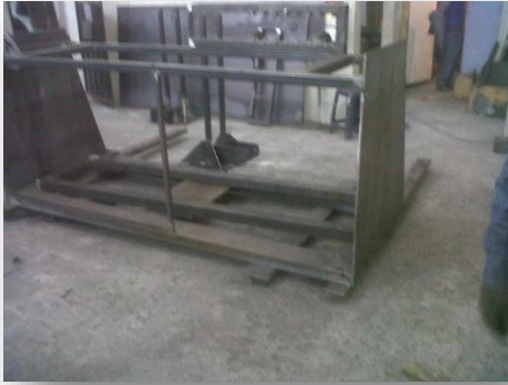
Figura 4.2. Construcción de la Estructura
