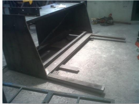
Figura 4.3. Construcción de la Estructura
