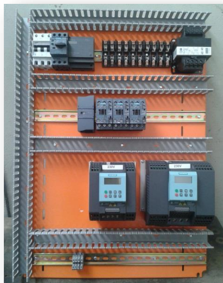
Figura 4.19. Colocación de Elementos Eléctricos en el Gabinete Metálico
