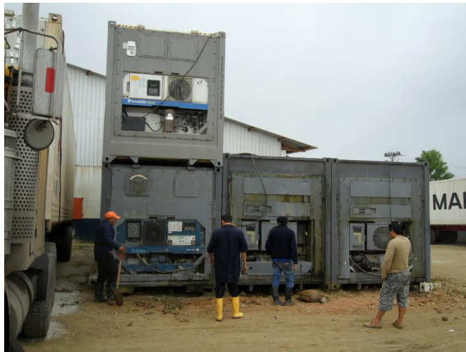
Figura 1.4 Mantenimiento contenedores distribución 4
