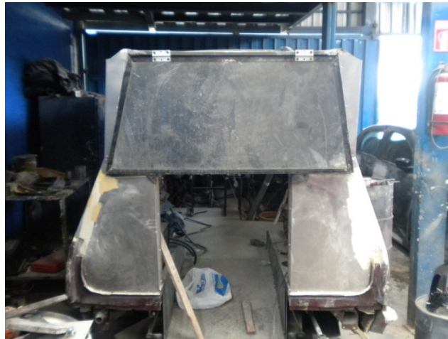
Figura 4.54. Recubrimiento de parte posterior.
