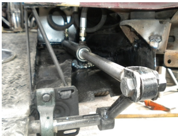
Figura 4.42. Instalación de Mangueras Alta presión
