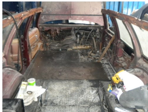
Figura 4.30. Instalación Nuevo Piso
