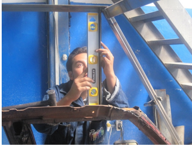
Figura 4.18. Verificación de la Perpendicularidad de la Estructura
