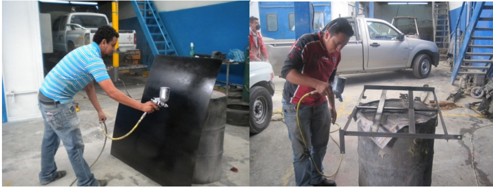
Figura 4.28. Aplicación de Pintura al Nuevo Piso
