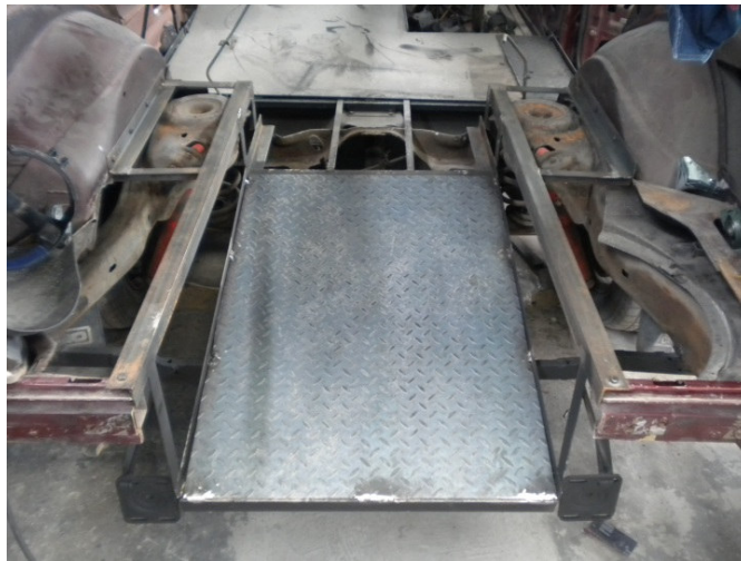
Figura 4.27. Montaje de Nuevo Piso
