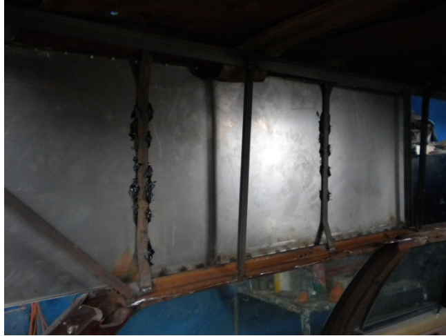
Figura 4.51. Aseguramiento de Paneles.
