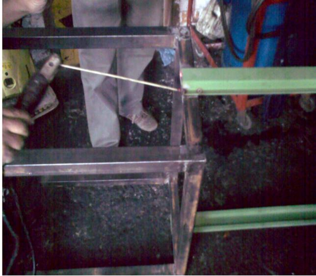
**Figura: 3.22** Unión de la segunda columna mediante suelda
