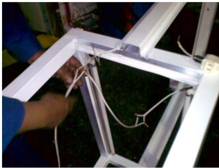
**Figura: 3.61** Conexión tripolar de las lámparas y mando máster
