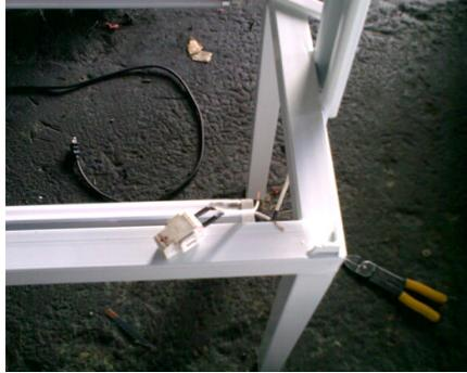
**Figura: 3.60** Conexión de lámparas fluorescentes
