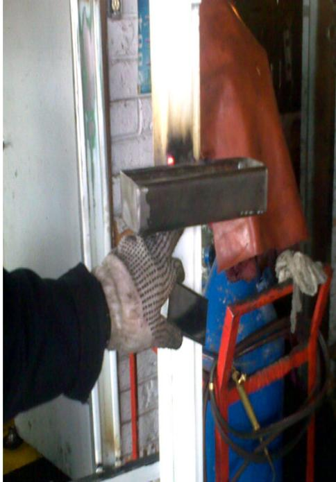
**Figura: 3.31** Unión del porta tintas a la columna de la estructura
