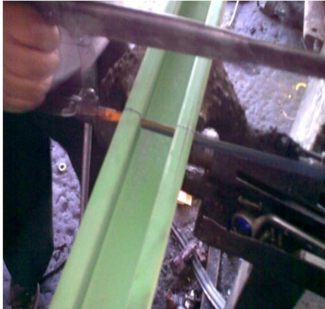
**Figura: 3.19** Corte de columnas
