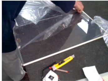
**Figura: 3.6** Corte en acrílico de la tapa superior de culata
