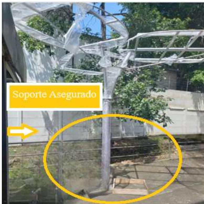
Para el proceso de implementación del árbol solar, se construyó una base de concreto en la cual se ancló una placa de acero en donde se soldó cada parte del árbol, véase la Figura
