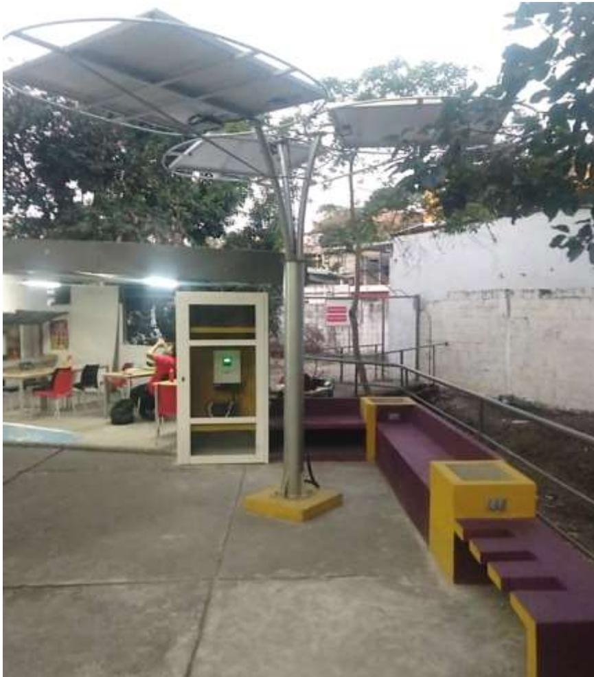
Considerando los componentes instalados con paneles solares con una capacidad de 900 Wp y 12 conectores de carga gracias a las 6 cajas instaladas, como se muestra en la figura
