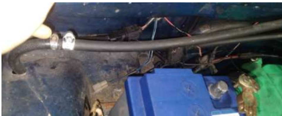
Instalación de Manguera Flexible de Combustible
