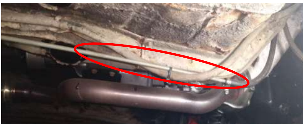
Instalación de Cañería de Combustible
