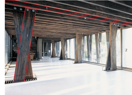
Figura 30. Materialidad de las oficinas, madera laminada
