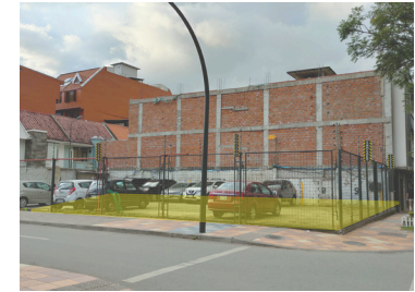
Figura 41. Estado actual garajes subutilizados, casco céntrico.
