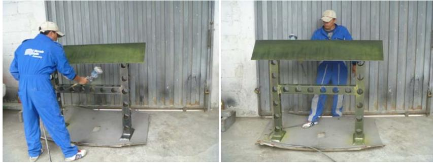
**Figura 4.25 Pintura con anticorrosivo a la estructura**
