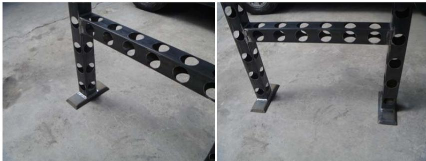
**Figura 4.22 Suelda de los pilares a las bases de la estructura.<sup>39</sup>**
