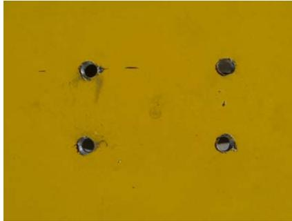
**Figura 4.44 Perforaciones de fijación para los reductores de flujo.**
