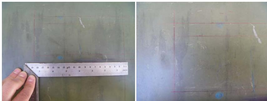
**Figura 4.33 Marcas de corte para la ubicación de soportes regulables.<sup>47</sup>**
