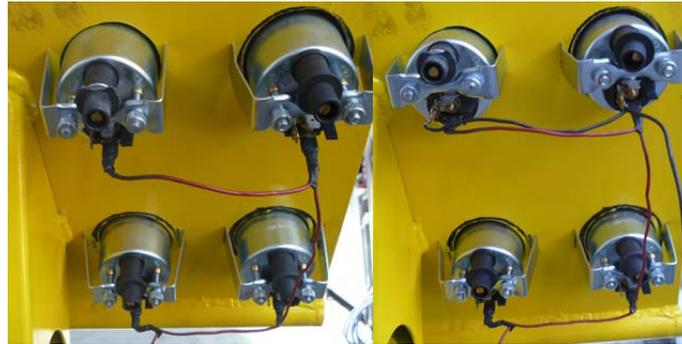
**Figura 4.56 Conexión de positivo y negativo de los manómetros e indicadores.**
