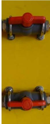
**Figura 4.46 Reductores de flujo instalados.<sup>56</sup>**
