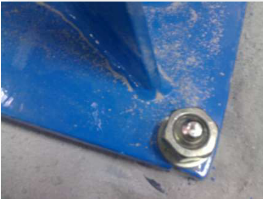
Figura 2.21 Ajuste de pernos expansivos
