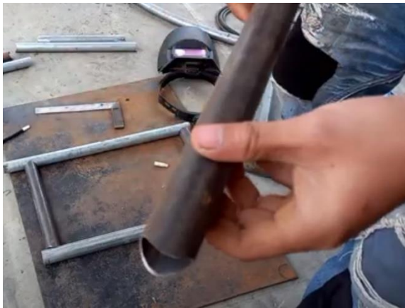
Corte de Tubos
