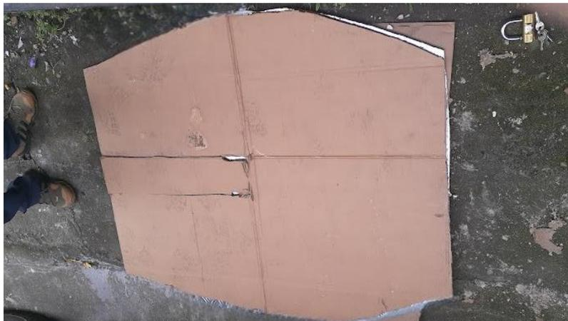
Después de terminar de cortar la pieza se realiza la comprobación de la pieza dentro del habitáculo, para asegurar de que esta no tenga problemas en entrar y para realizar sus respectivas correcciones debido a los tubos que ingresan al habitáculo; Como se muestra en la Figura 38.
