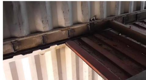
Figura 13. Apertura para gradas
