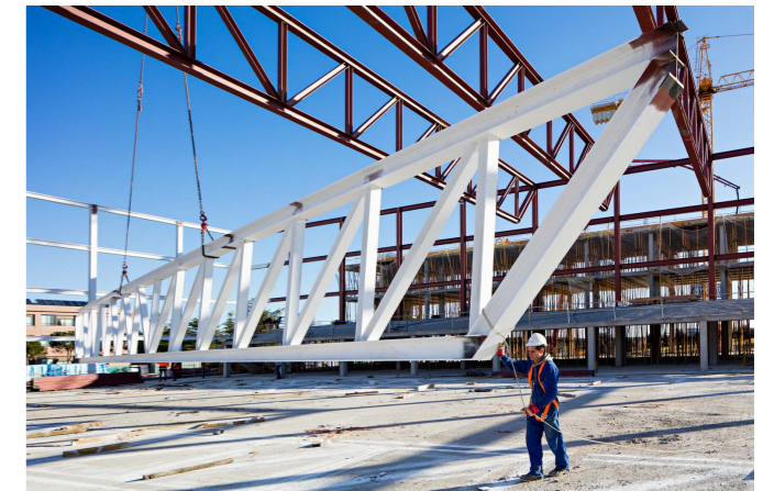
Figura 46. Cerchas que conforman la estructura Fuente: Alberto Campo Baeza (2017).
