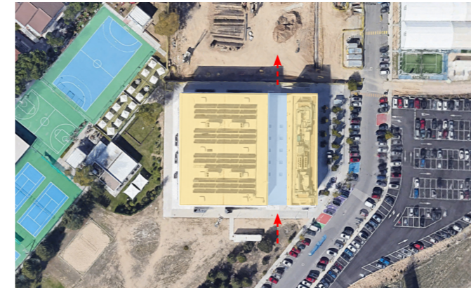
Figura 44. Ortofoto del Pabellón polideportivo Fuente: Google Earth.
