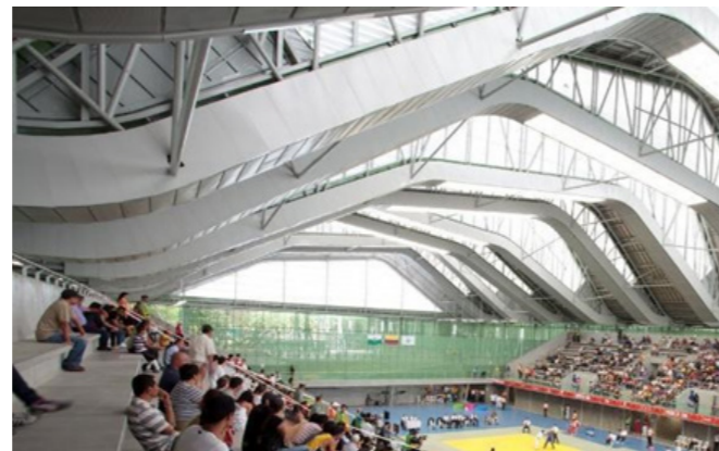
Figura 24. Cubierta con membrana de aglomerado Fuente: Plataforma Arquitectura
