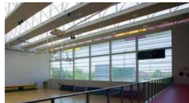
Figura 35. Estructura de pista polideportiva Fuente: www.ciudaddeportivalasolivas.com
