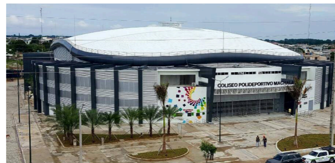
Figura 6. Coliseo polideportivo del cantón Machala. Fuente: Fotografía tomada de (Ministerio del deporte, 2017)
