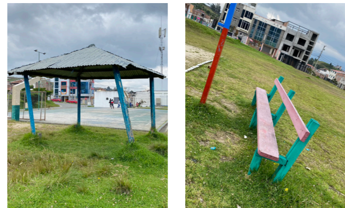
Figura 60. Fotografías del estado del mobiliario Elaborado por: Autor
