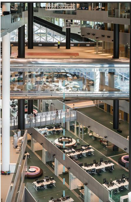
El puente funciona como casi toda la estructura del edificio, con estructura metálica y vidrio suspendida en los vacíos que, además de ser un lugar de paso, genera su función según la necesidad.
