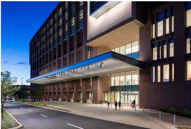
Fig 43. Entrada Principal / Centro de Articulaciones y Columna del Hospital de Cristo 2022.
