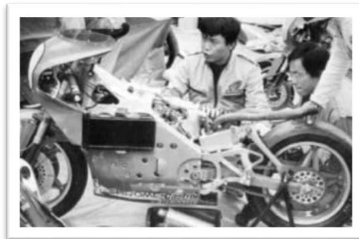
Figura 3.24 Bastidor Monocasco (Patxi Vergara Culebras, 2011)
