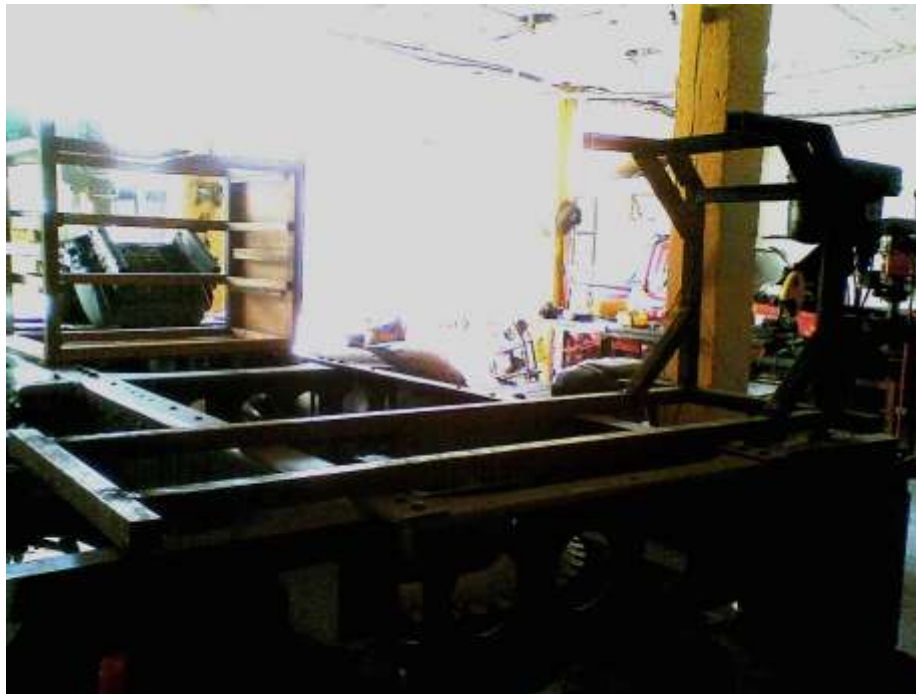
Figura 3. 53 Estructura metálica pintada Fuente: Jorge Vasconez y Juan Paredes
