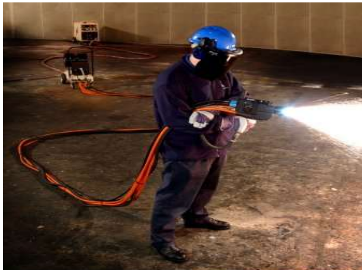
Figura 39. Equipos de protección para soldadura de ARC SPRAY
