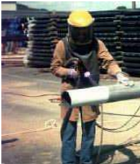
Figura 41. Metalización para protección anticorrosiva
