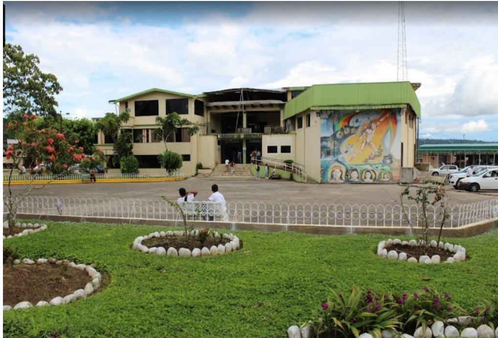
Figura 10 Instalaciones de la Unidad de Gestión de Riesgos del GADMA Archidona.
