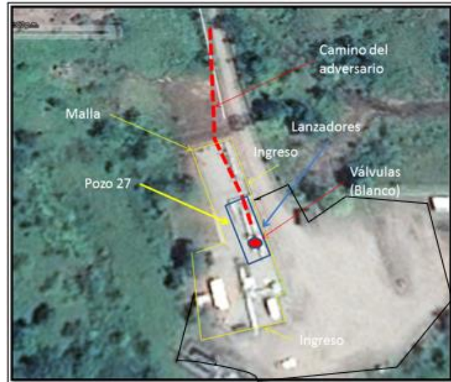
Camino del adversario pozo 27 antes de medidas
