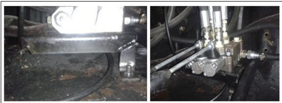
Gráfico 3.29 Reservorio instalándolo e instalado
