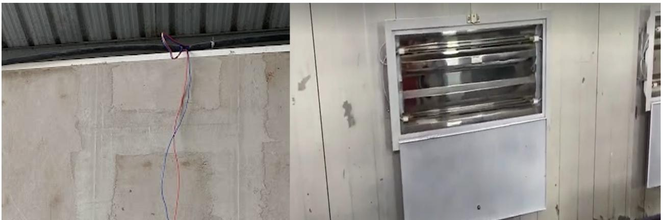
**Figura 24:** Instalación de quemadores
