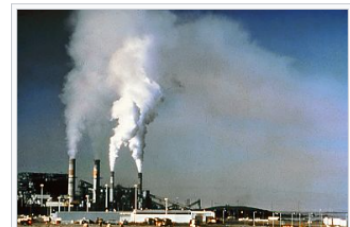
Esta planta generadora de Nuevo México libera dióxido de azufre y otros contaminantes del aire. 🔍
