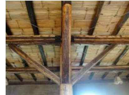
Ilustración 30: [Figura] Cubierta con tensores. Fuente: Arq. Valeria Bustos
