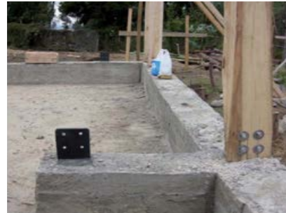
Ilustración 28: [Figura] Construcción de murito. Fuente: Arq. Valeria Bustos
