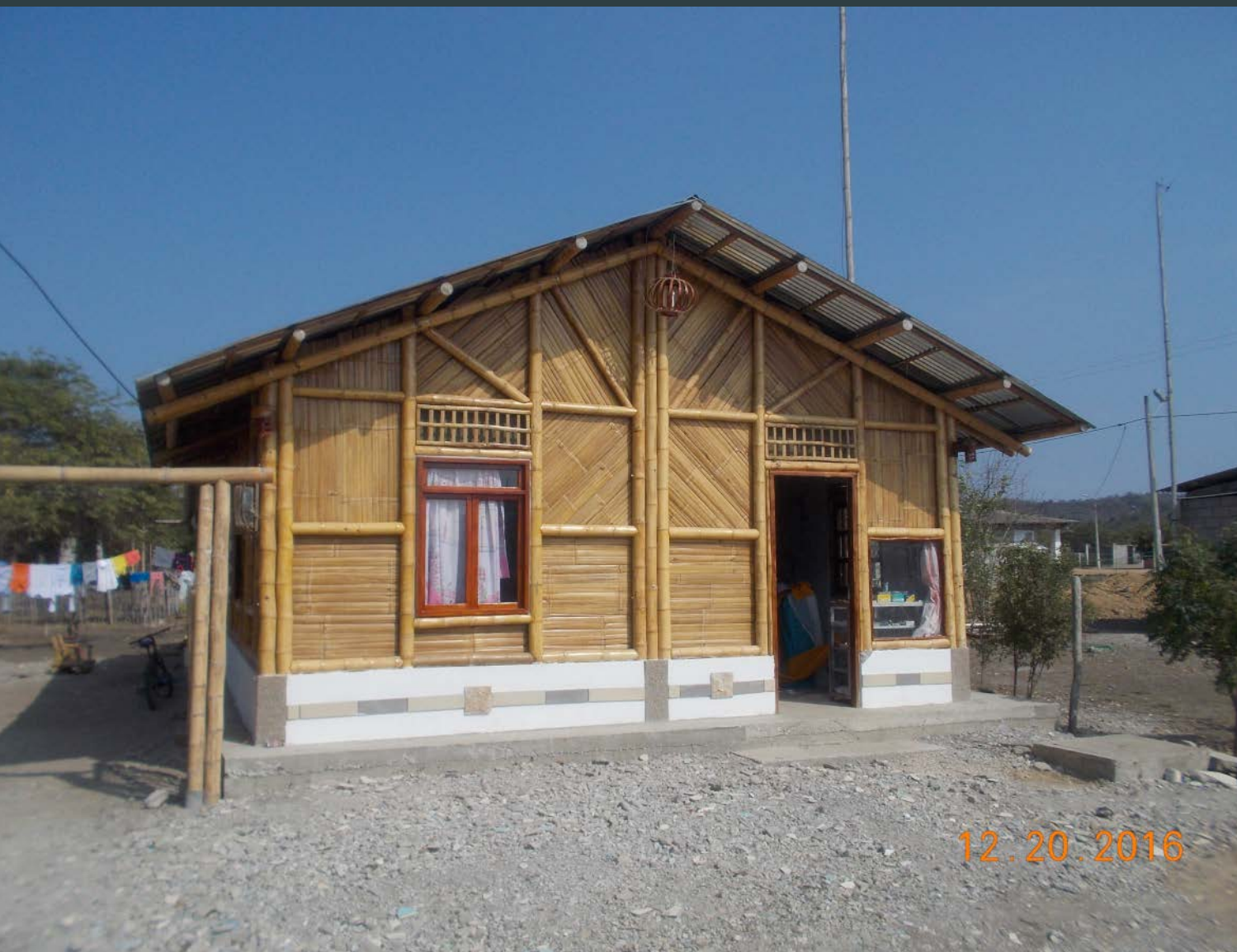
Ilustración 33: [Fotografía] de Klemver L. Casas libertador Bolívar. (Santa Elena, 2016) Fuente: Bambu Arquitectura
