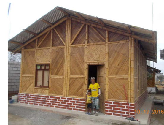
Ilustración 35: [Fotografía] de Klemver L. Casas libertador Bolívar. (Santa Elena, 2016) Fuente: Bambu Arquitectura
