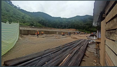
Ilustración 4 [Fotografía] de Autor. Estado actual del avance de la construcción del Bloque residencial Santa Elena. (Zamora, 2022). Fuente: Autor.
