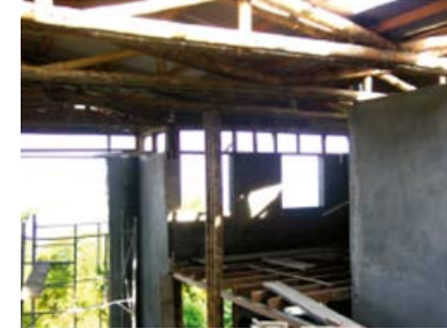
Ilustración 58: [Figura] Mampostería. Fuente: Arq. José Muñoz
