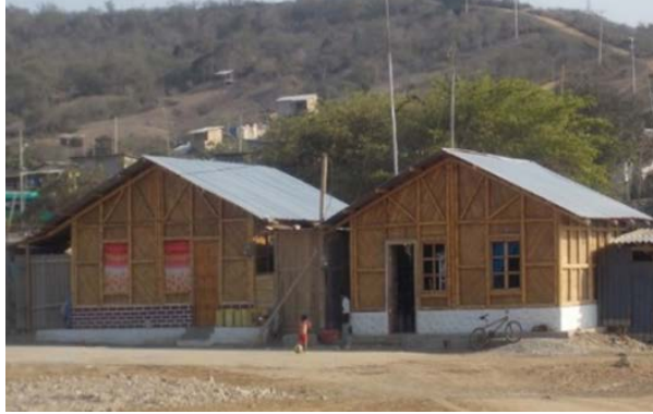
Ilustración 38: [Fotografía] de Klemver L. Casas libertador Bolívar. (Santa Elena, 2016) Fuente: Bambu Arquitectura
