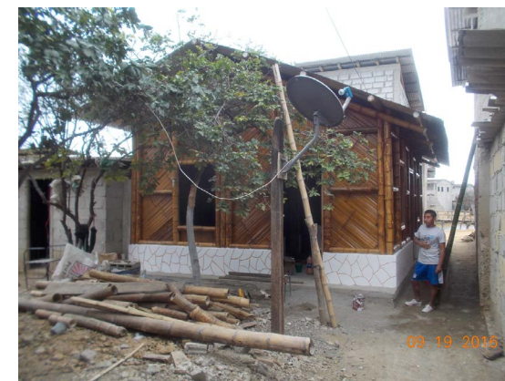
Ilustración 34: [Fotografía] de Klemver L. Casas libertador Bolívar. (Santa Elena, 2016) Fuente: Bambu Arquitectura
