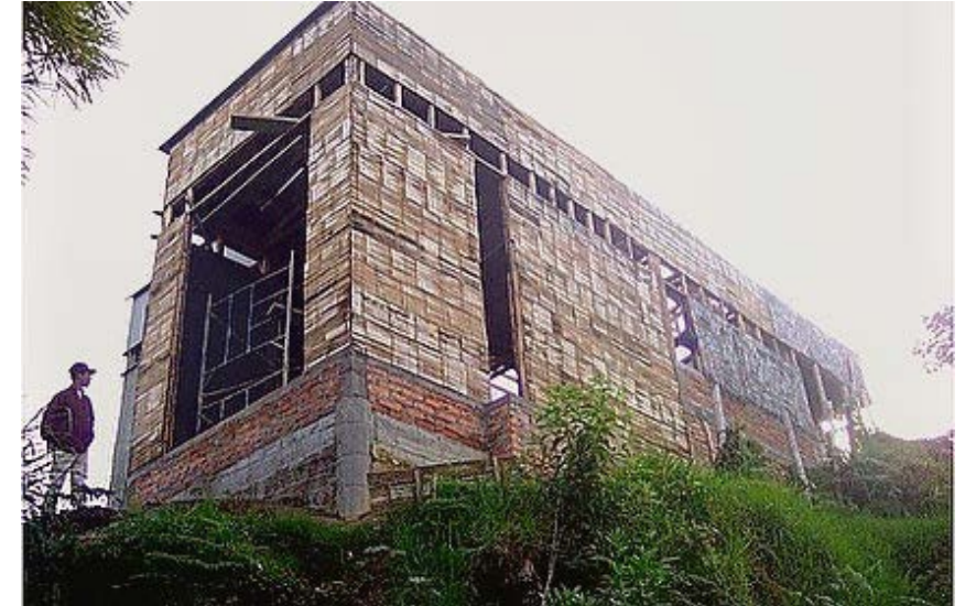
Ilustración 54: [Fotografía] de Muñoz J. Colocación de muros casa Santander. (Colombia, 2004) Fuente: Arq. José Muñoz
