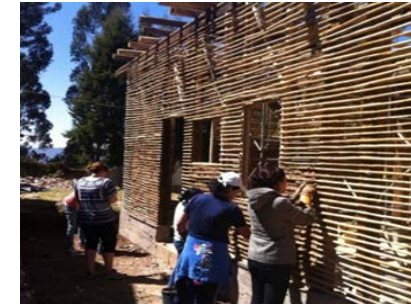
Ilustración 31: [Figura] Colocación de muros. Fuente: Arq. Valeria Bustos
