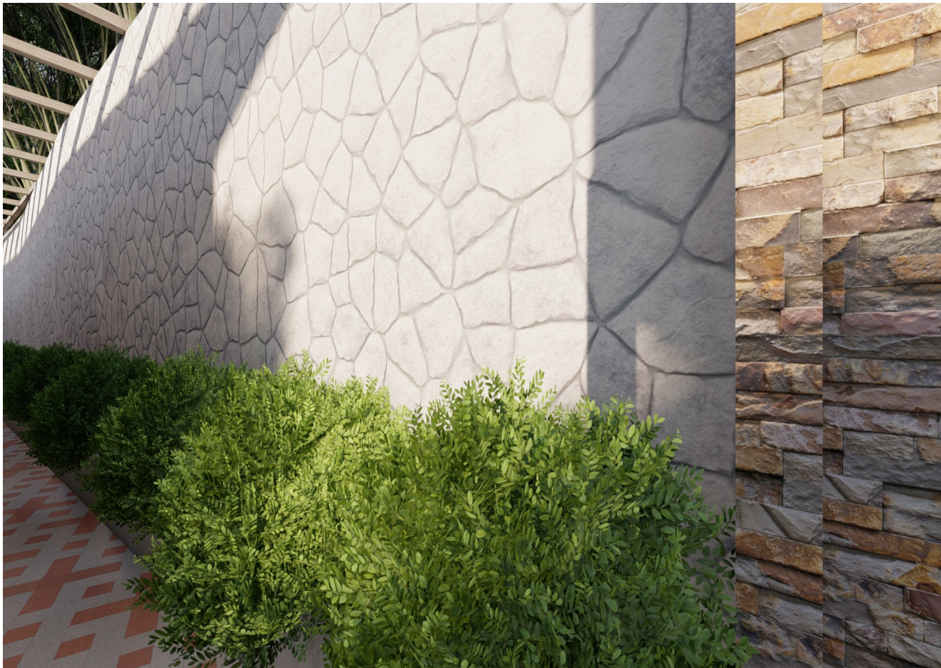
Imagen 75: Vista hacia el muro de contención
