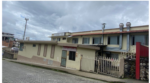
Imagen 32. Identificación de la fachada Este
