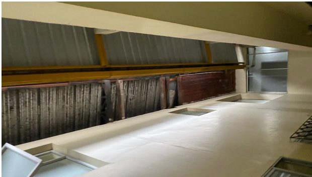
Imagen 30. Identificación de la cubierta
