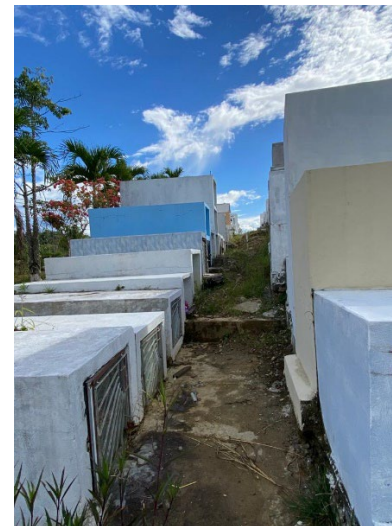
Nota. Inexistencia de sistema de drenaje [Fotografía], por Jimenez, 2022
