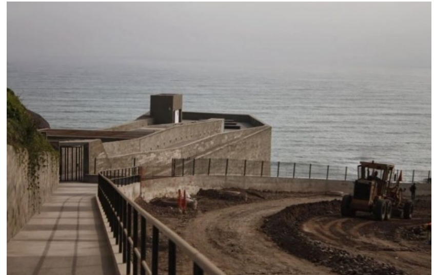
Ilustración 30. Acceso hacia el proyecto
