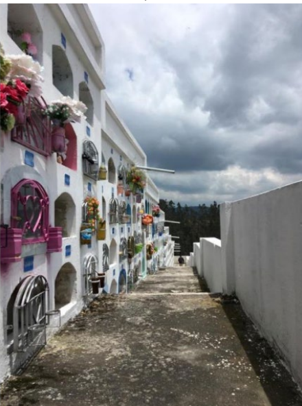
Ilustración 38. Bloques de nichos del Cementerio de Tulcán
