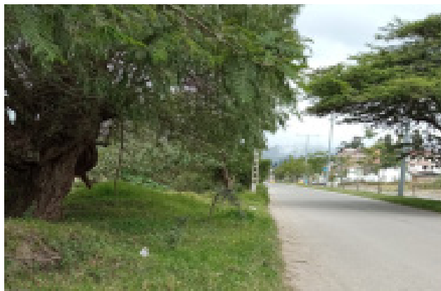
Figura 25. Carencia de aceras en el exterior del terreno
