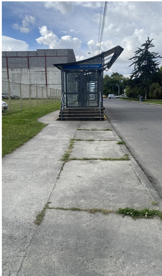
Imagen 23. Aceras del sitio de intervención Nota. Adaptado por el autor
