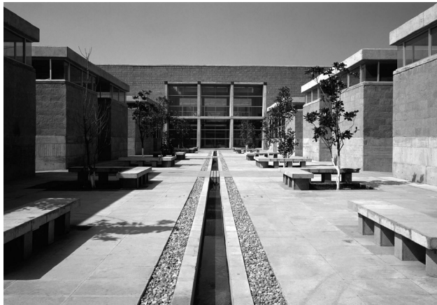
Imagen 03. Centro de invidentes y débiles visuales. Nota. Adaptado de la Plataforma arquitectura por Gordoa.
