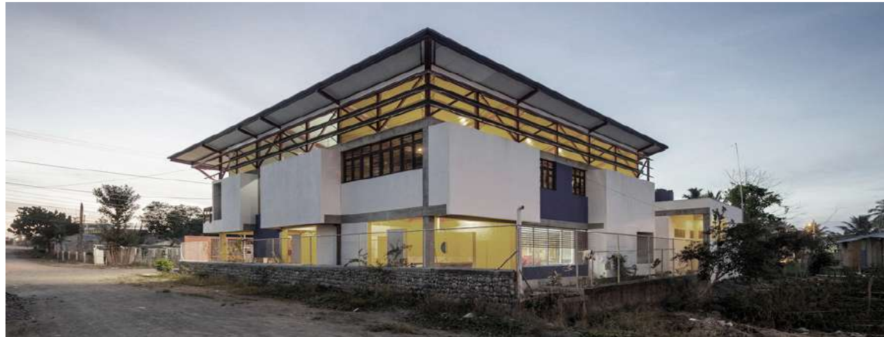
Figura 12. Exterior de la Casa Albergue Nota: La imagen representa el modelo de la parte exterior de la casa albergue propuesta, basada a partir del trabajo de MCM+A taller de arquitectura, (2006).
