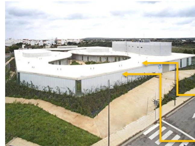
Losa Hormigón Armado
