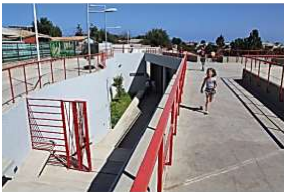
Vista acceso principal
