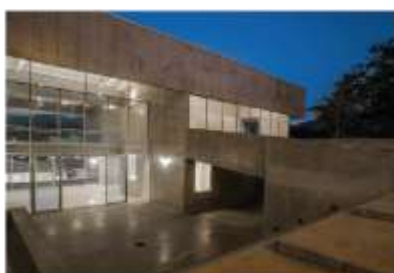
Vista acceso principal
