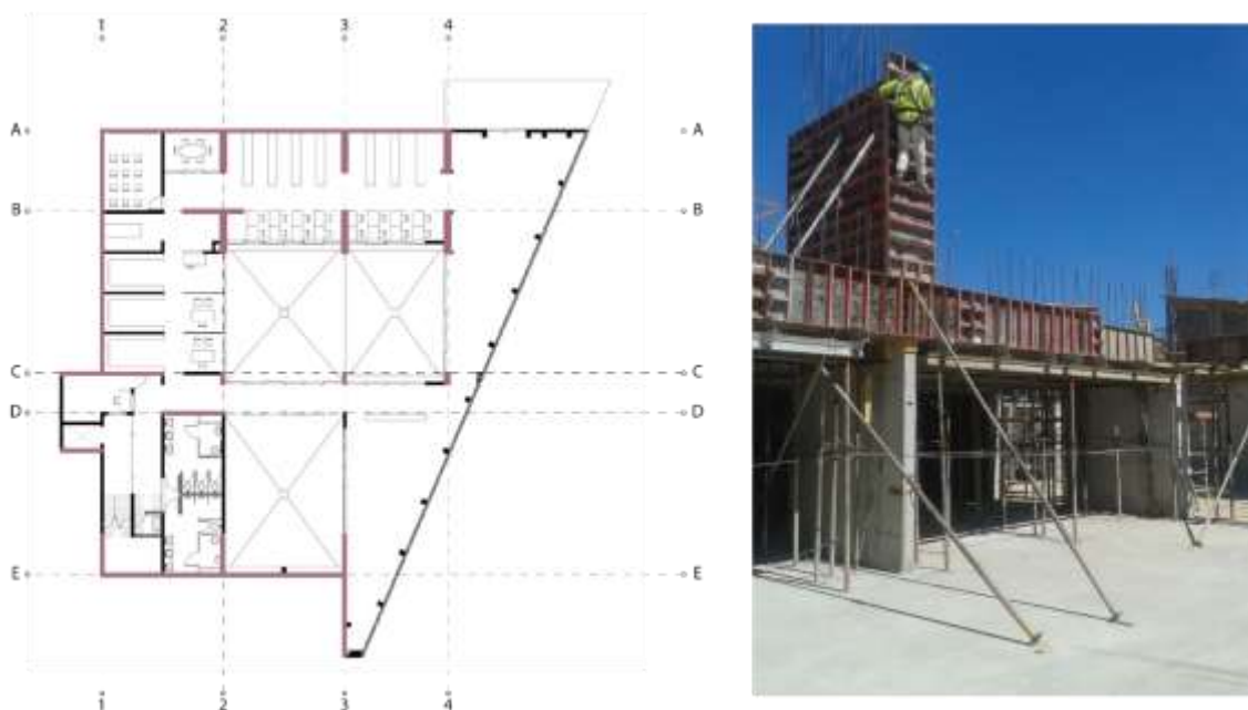
Ilustración 44. Estructura de diafragmas
