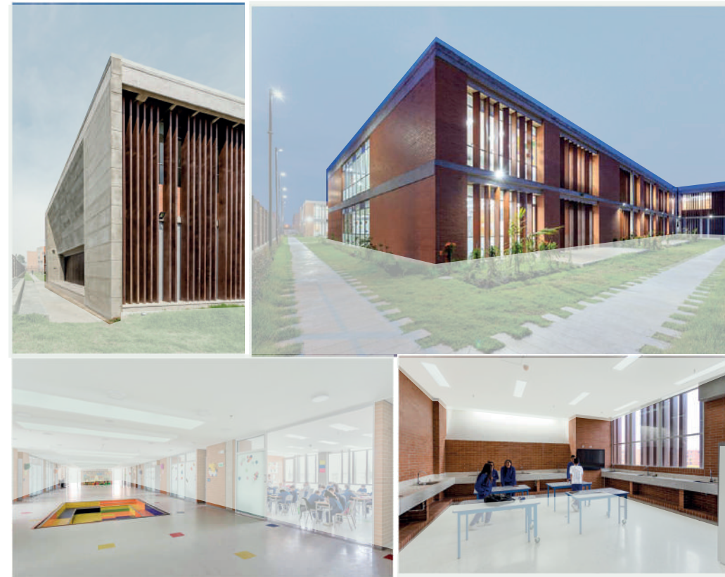
Ilustración 22. Materialidad interior - exterior Fuente: Elaboración propia
