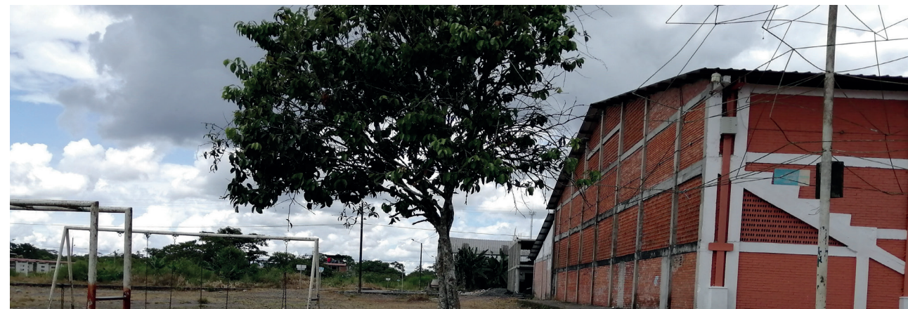
Figura 40. Vista Frontal del equipamiento
