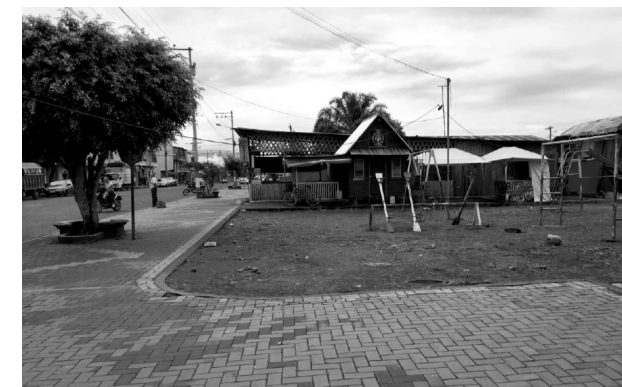
Figura 7. Vista frontal esquina lateral derecha del equipamiento
